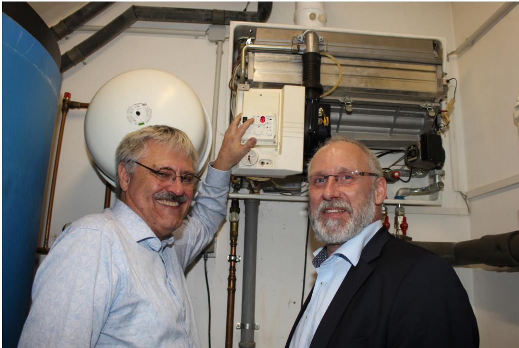
Hat bald ausgedient: Uwe Kramer (links) und Andreas Arendt vom SVW 06 Ahnatal zeigen die alte Heizungsanlage, die in den kommenden Wochen durch eine neue ersetzt wird. Foto: Meike Schilling
